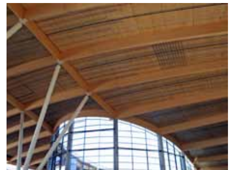
Größte Holzbaustelle Europas.
