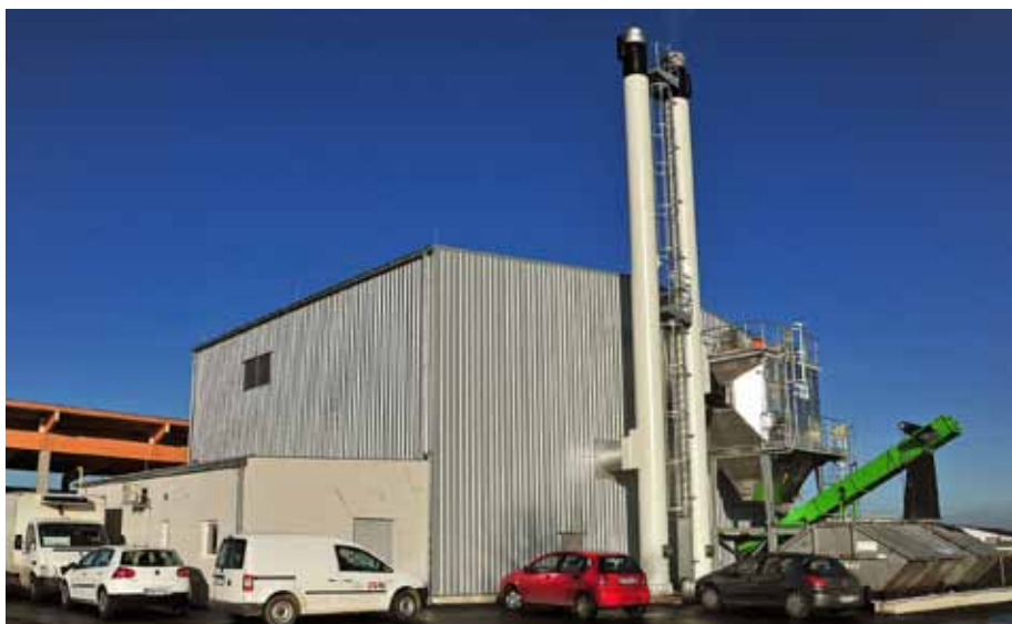
Das Biomassefernheizwerk der EVN in Hagenbrunn versorgt das G3 Shopping Resort Geradorf mit der benötigten Energie.
