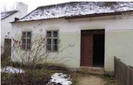
Abb. 1: Das konstruktive Element des Entlastungsbogens wird in der Fassade als Zierelement aufgenommen und betont. Sattlerhaus aus Niedersulz, Museumsdorf Niedersulz, Foto: Bieber 2014
