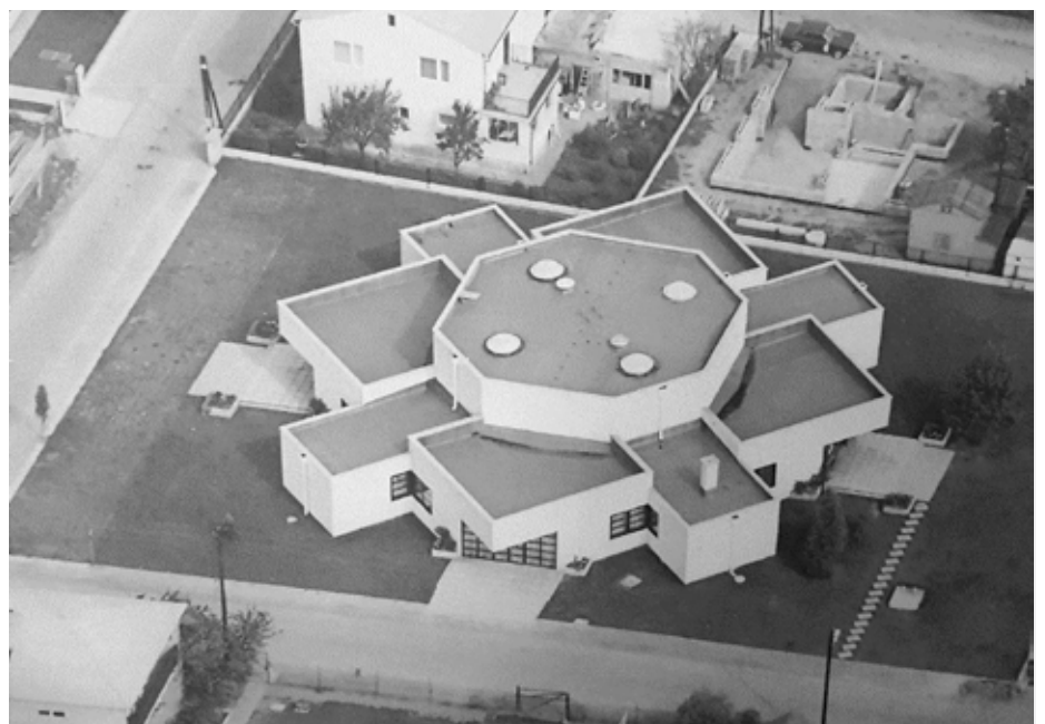
Abbildung 1: PFARRKIRCHE KAPELLERFELD VOR ERRICHTUNG DES GLOCKENTURMS
