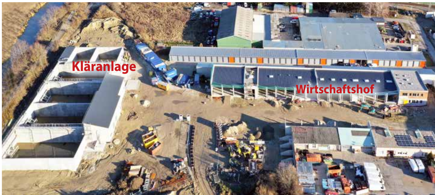
Drohnenfoto von der Baustelle in der Fabriksgasse - Ende Dezember 2021 (Foto: City Copter Cam)
