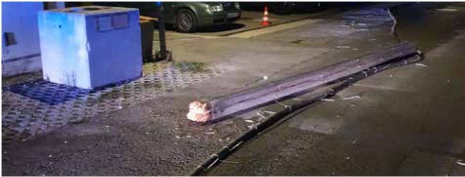
Einer der beiden umgestürzte Baustellenstrommasten in der Franz Wallner Gasse. (Foto: FF Gerasdorf)
