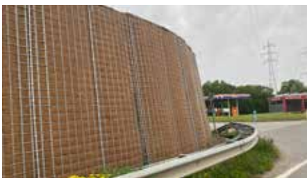
Nachhaltiger Lärmschutz: Die Klimawand wird in Zukunft mit Pflanzen zuwachsen (Foto: GGGK)
