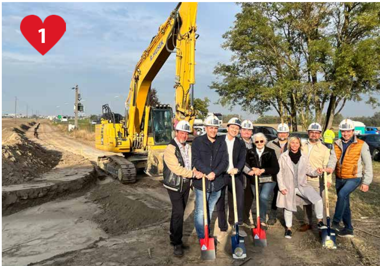
Radweg vom Gerasdorfer Zentrum zur U1 Leopoldau
